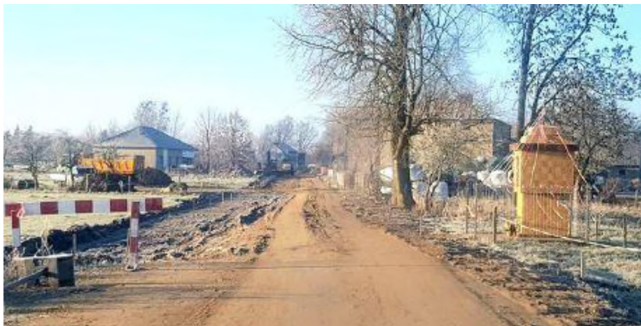
Ryc. Budowa drogi w Rembielinie, źródło: Urząd Miasta i Gminy w Chorzelach
