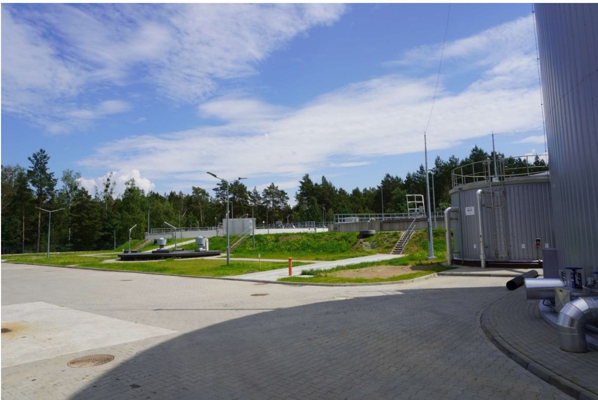
Ryc. Przebudowa i rozbudowa miejskiej oczyszczalni ścieków w Chorzelach, źródło: Urząd Miasta i Gminy w Chorzelach
