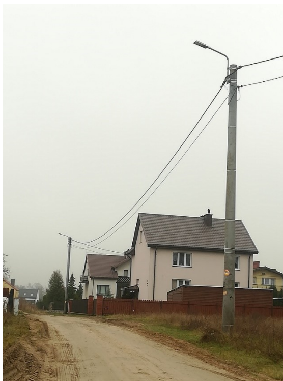
Ryc. Dwie lampy oświetlenia ulicznego LED o mocy 50W każda, dowieszone na ul. Stara Targowica w Chorzelach, Źródło: Urząd Miasta i Gminy w Chorzelach
