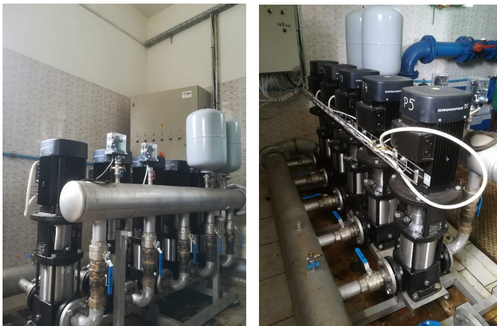
Ryc. Zestaw Hydroforowy w SUW w Zaręczach, źródło: Urząd Miasta i Gminy w Chorzelach
