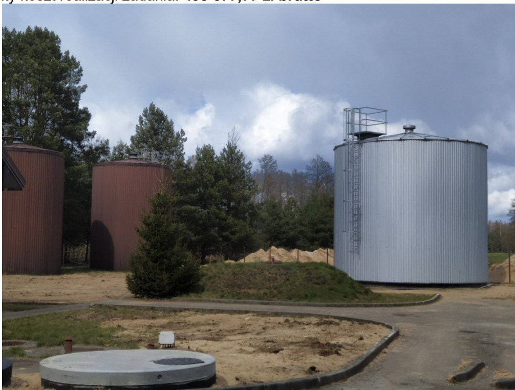
Ryc. Rozbudowa Stacji Uzdatniania Wody w Zarębach – etap I, źródło: Urząd Miasta i Gminy w Chorzelach
