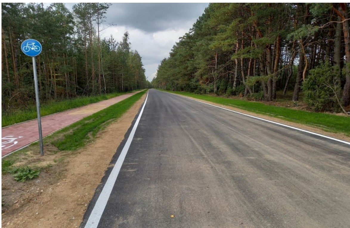
Rysunek 16 „Przebudowa drogi gminnej w miejscowości Opalenie wraz z rozbudową drogi gminnej
