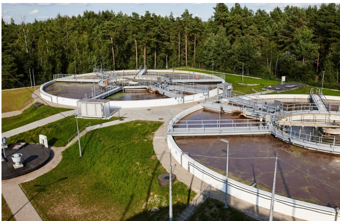
Rysunek 19 Przebudowa i rozbudowa miejskiej oczyszczalni ścieków w Chorzelach, ob. nr 5A i ob. nr 5B wielofunkcyjne reaktory biologiczne, źródło: Urząd Miasta i Gminy w Chorzelach
