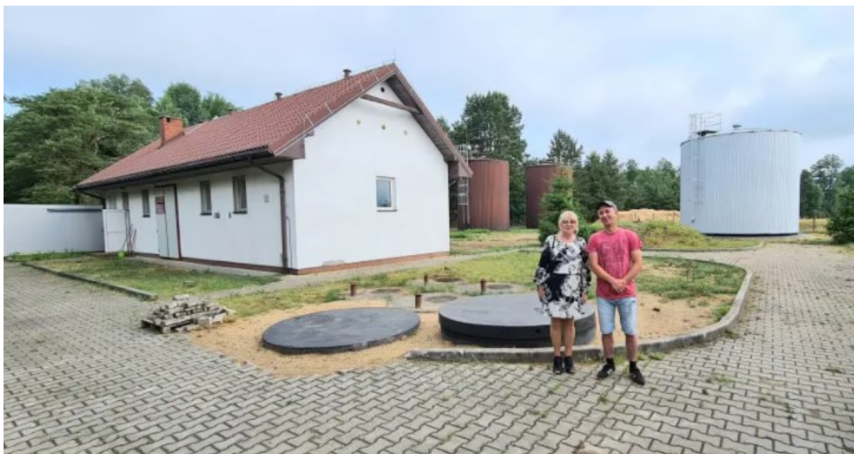
Rysunek 18 Stacja Uzdatniania Wody w miejscowości Zaręby, źródło: Urząd Miasta i Gminy w Chorzelach
