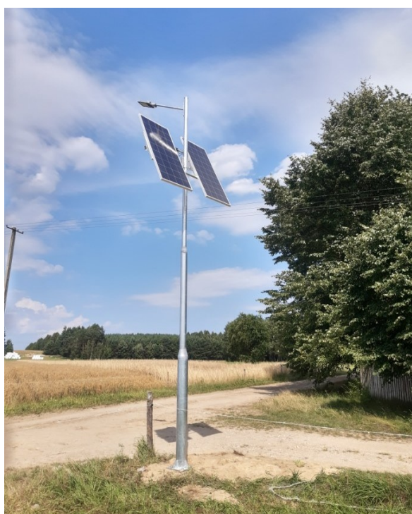
Rysunek 22 Punkt solarnego oświetlenia ulicznego LED o mocy 35W w miejscowości Nowa Wieś, Źródło: Urząd Miasta i Gminy w Chorzelach.
