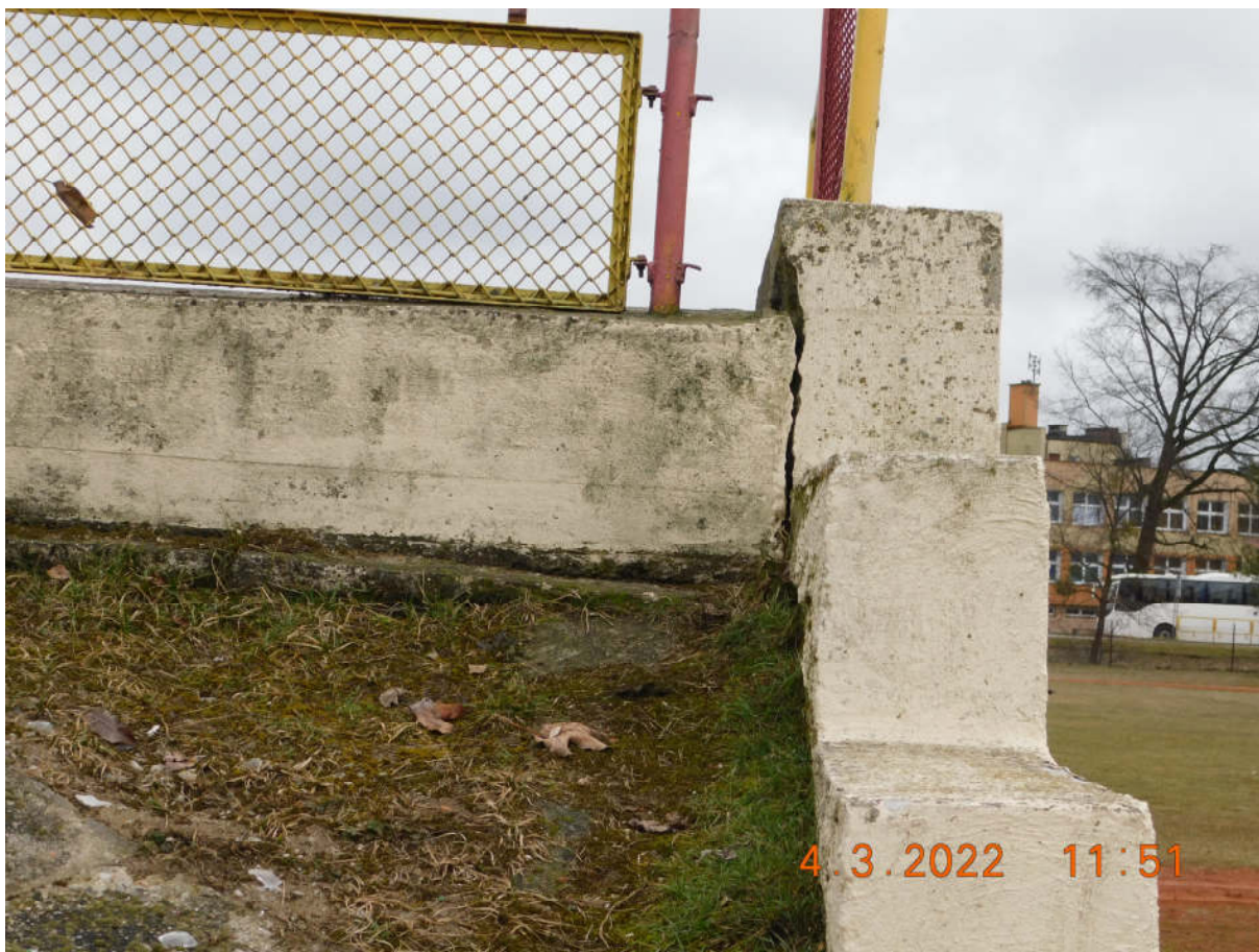
Fot. 4 Pęknięcia na styku ściany z konstrukcją główną trybun
