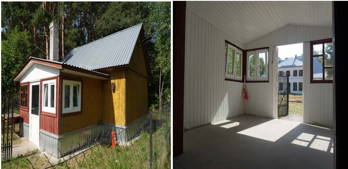
Rysunek 50 Remont świetlicy wiejskiej w miejscowości Rawki, źródło: Urząd Miasta i Gminy w Chorzelach
