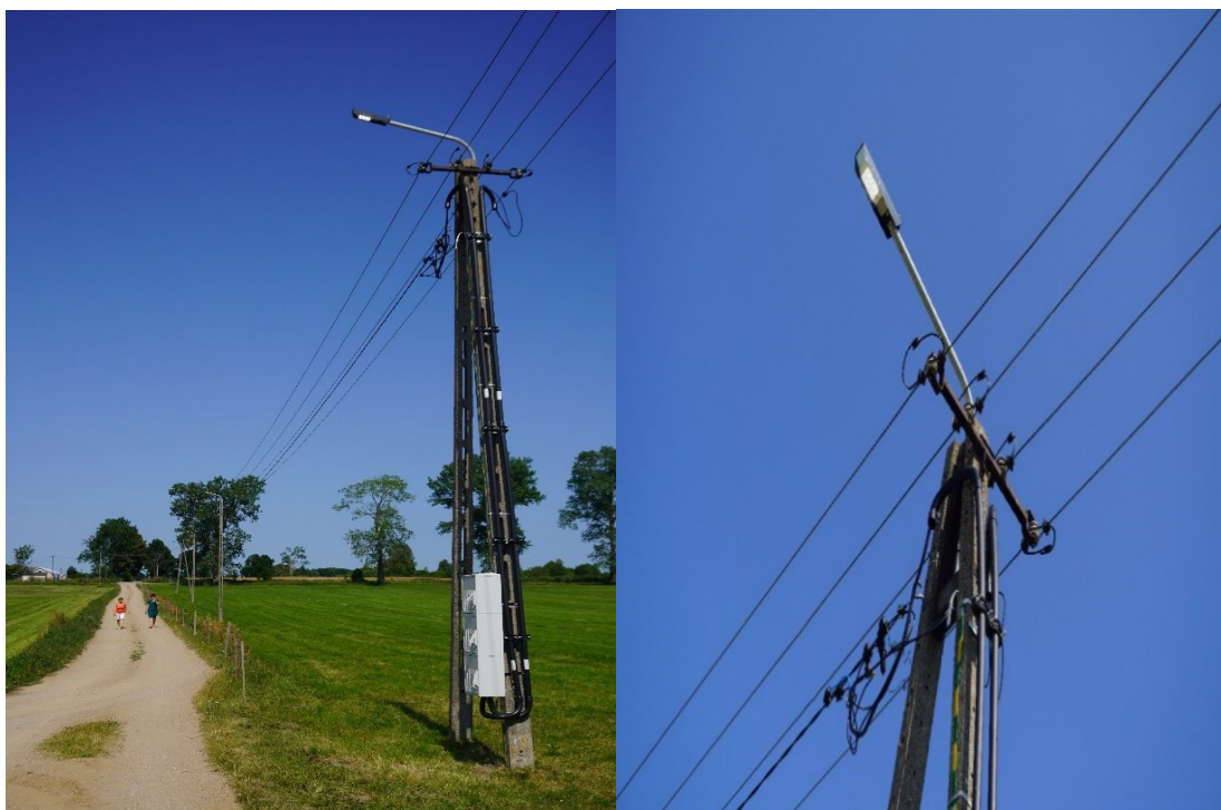
Rysunek 64 Dowieszono oprawy oświetlenia ulicznego LED o mocy 30W w miejscowości Gadomiec Chrzczany, Źródło: Urząd Miasta i Gminy w Chorzeliach, źródło: Urząd Miasta i Gminy w Chorzeliach
