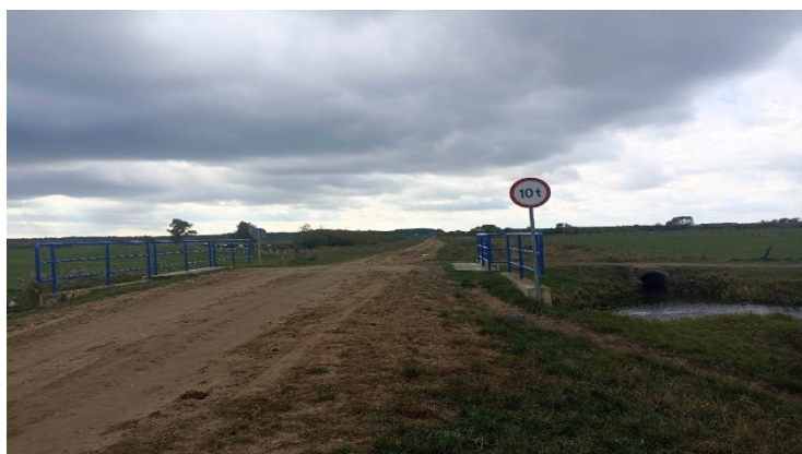
Rysunek 138 Konserwacja mostu w Krukowie, źródło: Urząd Miasta i Gminy w Chorzelach
