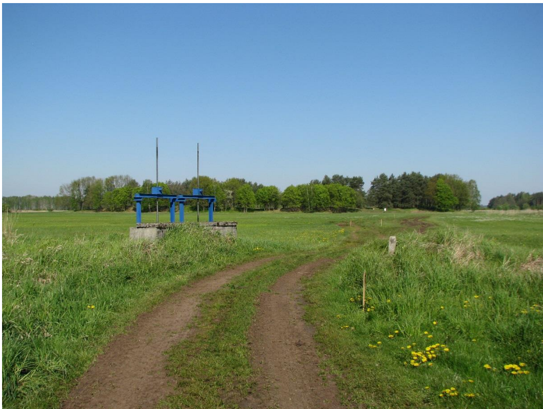
Ryc. 17. Mostek nad Dzierżąską wraz z przepustem. Widok na Łysą Górę, na wprost widoczne wytyczenie przebiegu nowej drogi dojazdowej do stanowiska
