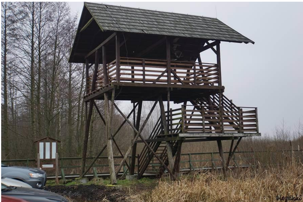
Ryc. 26. Wieża widokowa na szlaku ścieżki edukacyjnej „Bagno Całowanie”, gm. Celestynów
